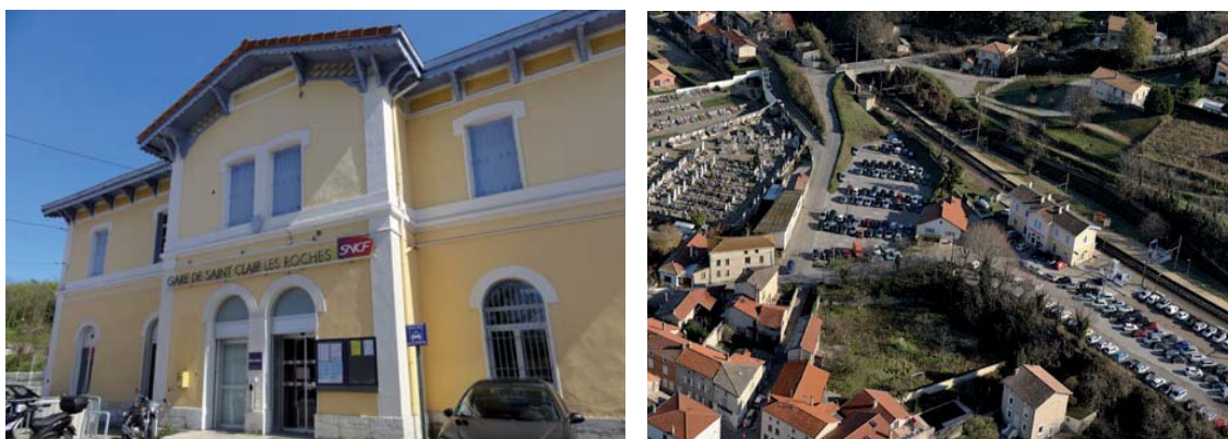
Gare de Saint-Clair – Les Roches et vue aérienne du site (Source : CCPR)
