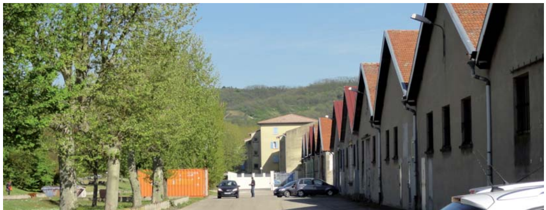
Façade Nord des bâtiments rue de Champagnole
