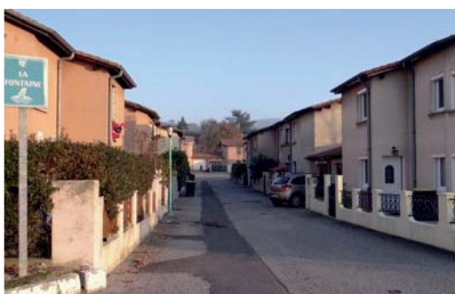
Rues pavillonnaires privées avec un espace mixte piétons/voitures
