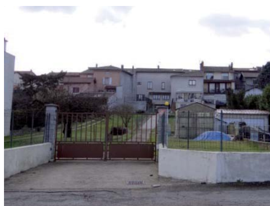
Abords du port et clôture le long de la RD 4
