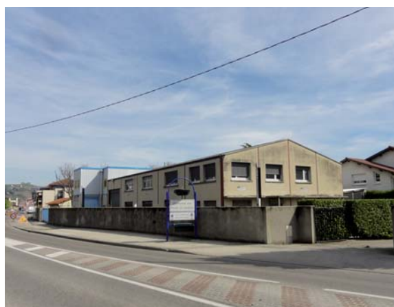
Exemples de locaux d'activités vacants, rue de Grand Terre et sur la RD 4
