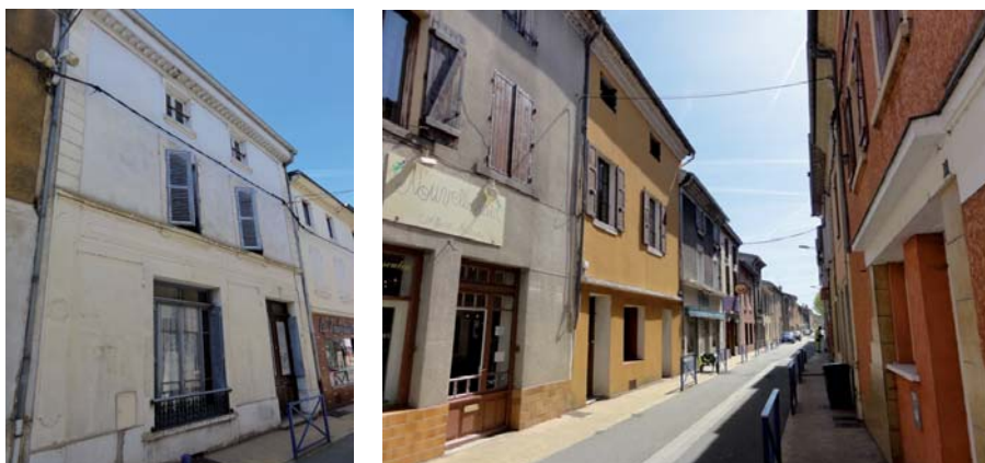
Maisons de ville dans le centre ancien
