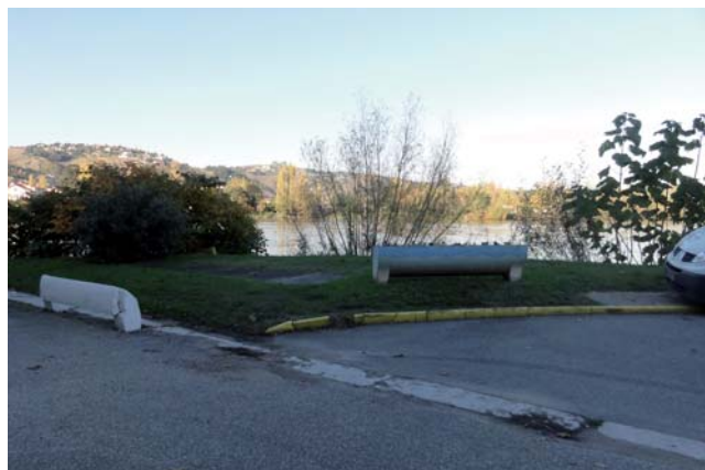
Manque de continuité dans les aménagements piétonniers le long du port
