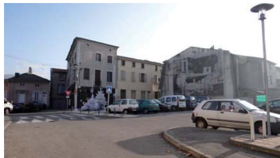
Place du Carcan issue d'une démolition dans le cœur ancien
