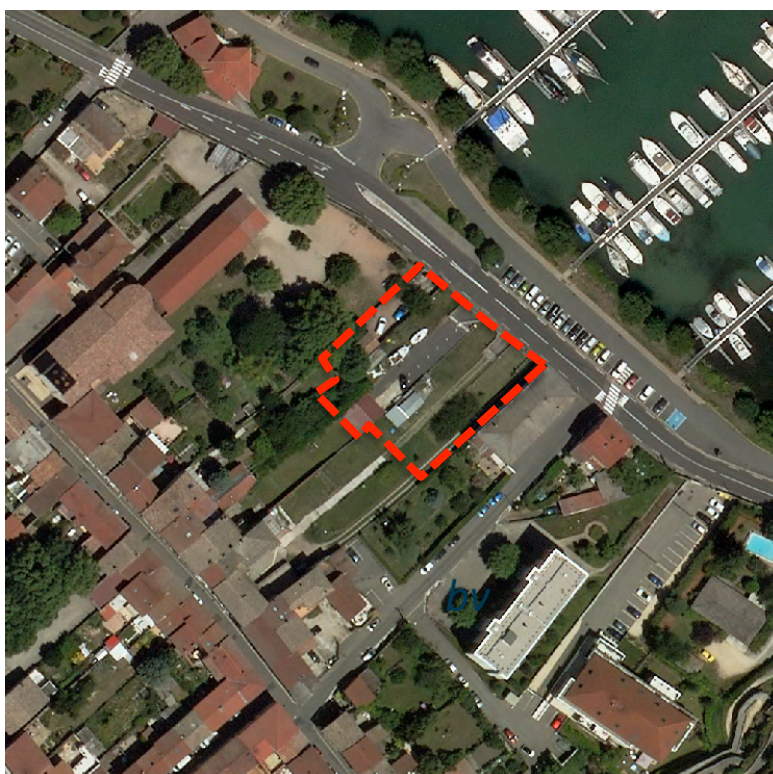
Périmètre de projet sur photographie aérienne (Source : SMRR 2015)
